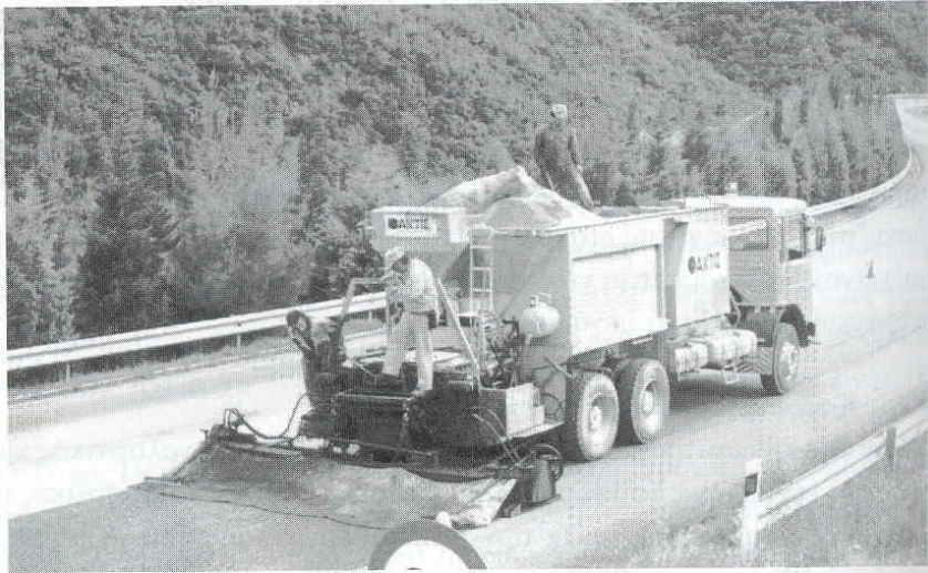
Φωτογραφία 1. Μηχάνημα παραγωγής και διάστρωσης μιγμάτων slurry
